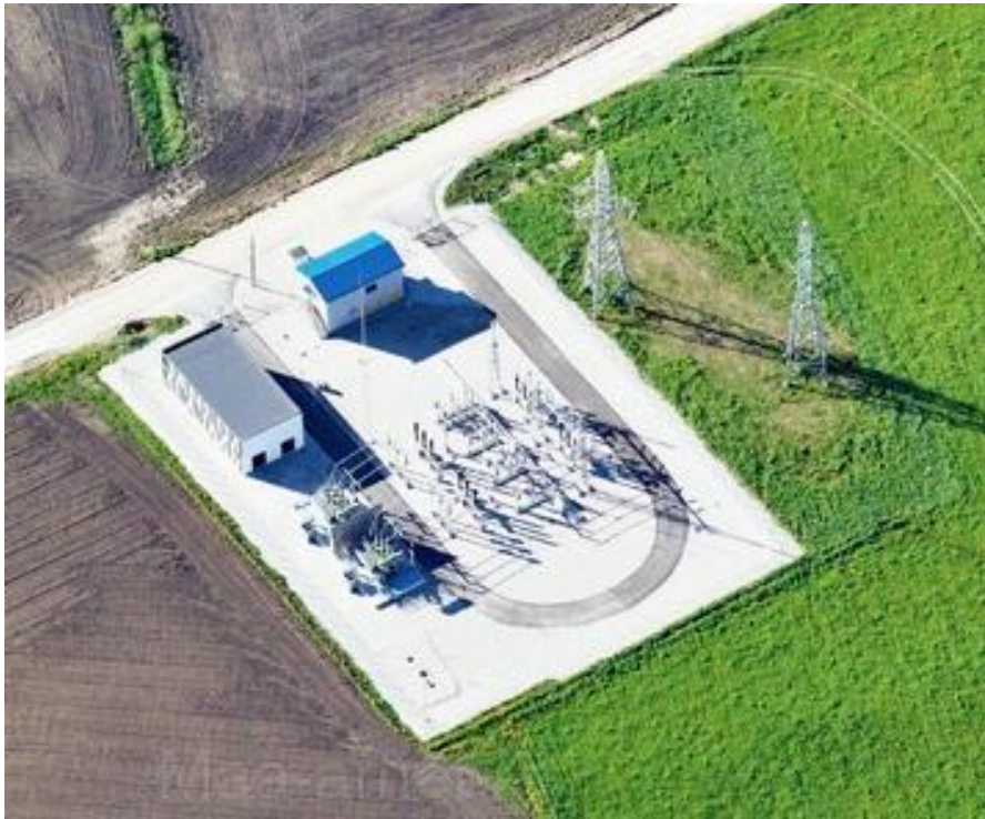
Joonis 6. 110 kV alajaama illustratsioon – Jänera alajaam. Allikas: Maa- ja Ruumiameti kaldaerofoto.
