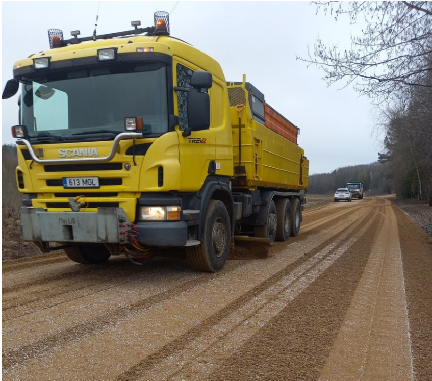
Joonis 4. Kulumiskiht segatakse ja viimistletakse baasauto alussahaga.
