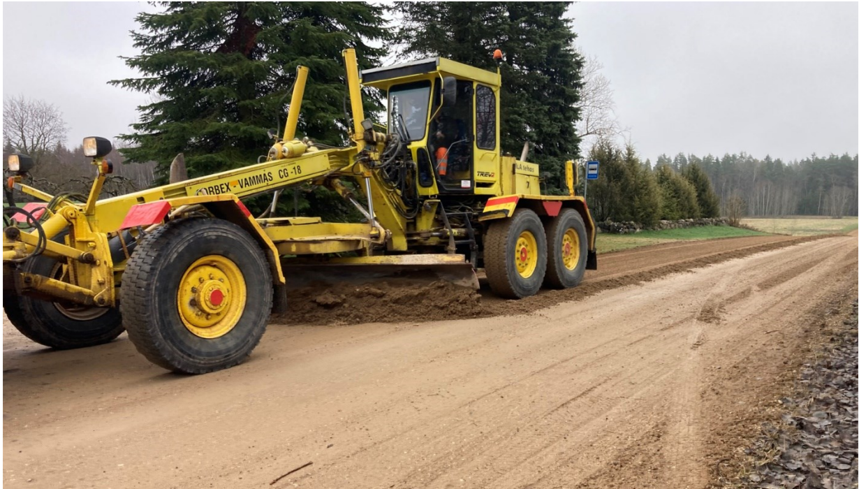
Joonis 2. Kruuskatte kobestamine ja profileerimine enne tolmutõrjet.
