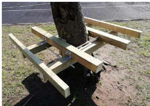
Foto 7. Keermelattidega platvormi puutüve külge kinnitamine
