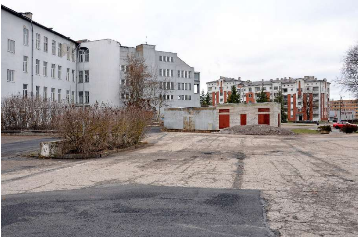
30. Üks ilmetumaid kasutuseta kohti Valga linnatuumiku muinsuskaitsealal. Tegemist on Vabaduse 3 ja 5 tagaküljele jääva kinnistuga, kuhu on juurdepääs mitmelt poolt ja mida läbikäiguhoovina ka aktiivselt kasutatakse. Foto 2016.
