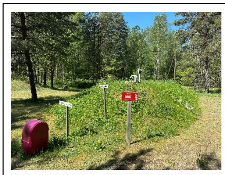
Fotod 4.15 Kalliküla küla tuletõrje veemahuti ja hüdrant 2024. aastal.
