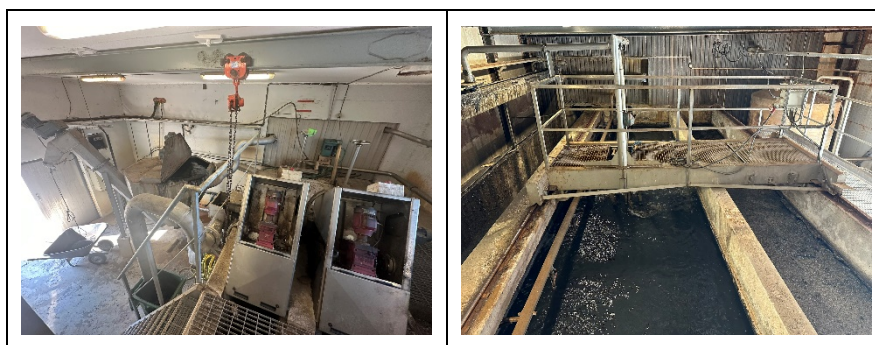
Fotod 5.2 Valga RVP liivapüünis ja võrekanalid 2024. aastal.
