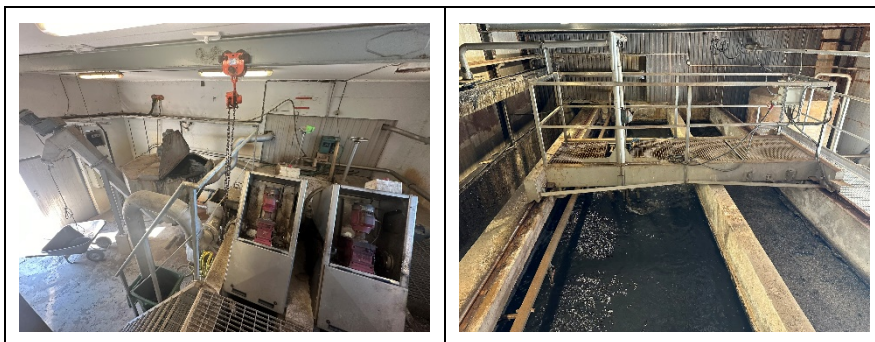
Fotod 5.2 Valga RVP liivapüünis ja võrekanalid 2024. aastal.
